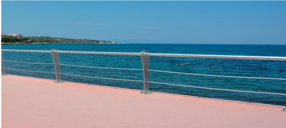
Şekil 2.10. Deniz kenarı korkuluklarında
