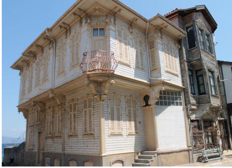
Şekil 4.12. Geleneksel yapılardaki malzeme kullanımı örneği
