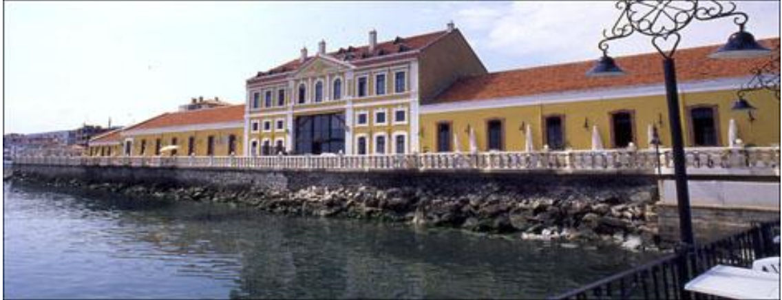
Şekil 3.15. Günümüzde otel olarak kullanılan Mudanya Gümrük Binası
