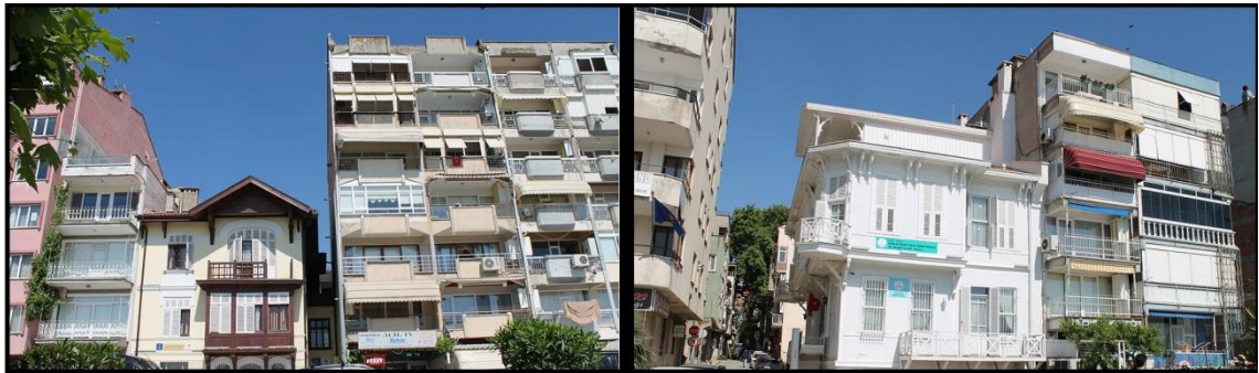
Şekil 4.32. Tarihi yapılar ve çevredeki diğer yapıların görünümü
