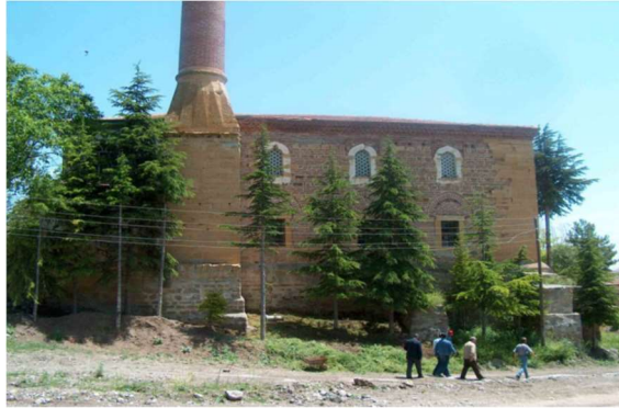
Şekil 2.8. Taş tuğla karışımı taşıyıcı kargir duvar.
