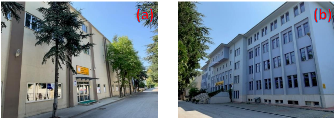
Şekil 3.46. Hisar Anadolu Lisesi giriş cephesi-2019(a), Koza Meslek ve Teknik Anadolu Lisesi giriş cephesi-2019(b)
