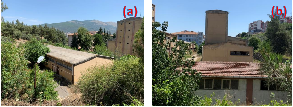
Şekil 3.58. Nitro selüloz ambarı ve laklama binası-2019(a), destilasyon kulesi ve solvent depoları binası-2019(b)
