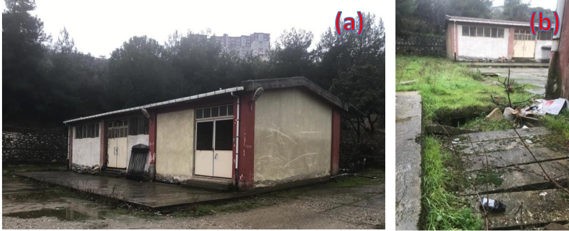
Şekil 3.54. Solvent depo tankları binası-2018(a), yeraltı kanalları-2018(b)
