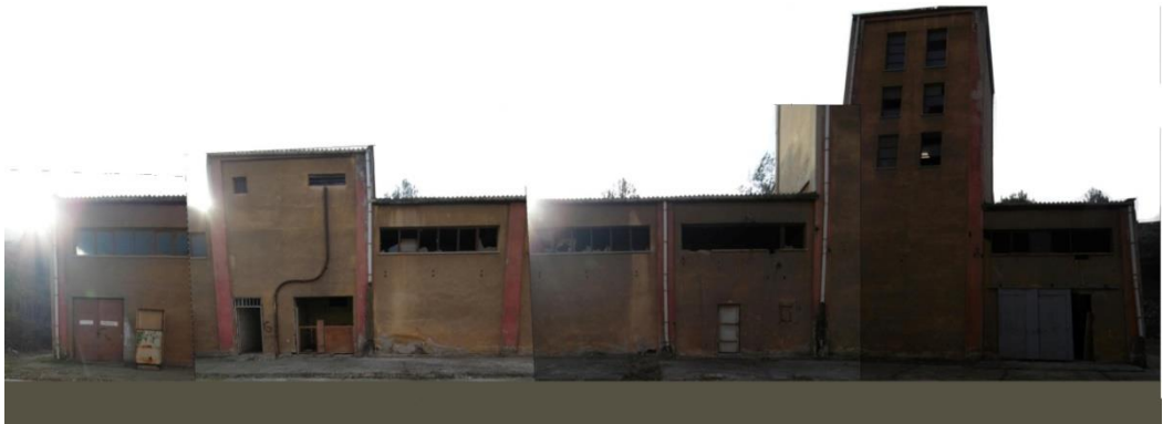
Şekil 4.13. Lak hazırlama ve solvent geri kazanım binası kuzey fotoğrafı
