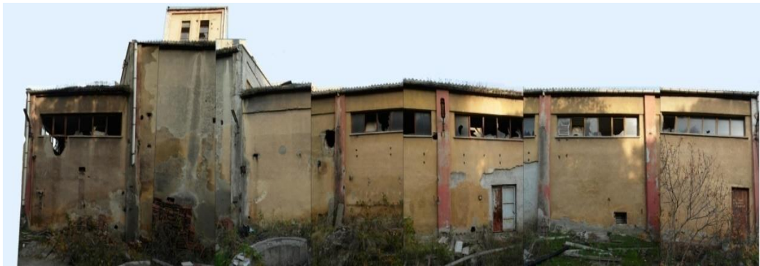
Şekil 4.15. Lak hazırlama ve solvent geri kazanım binası güney fotoğrafı
