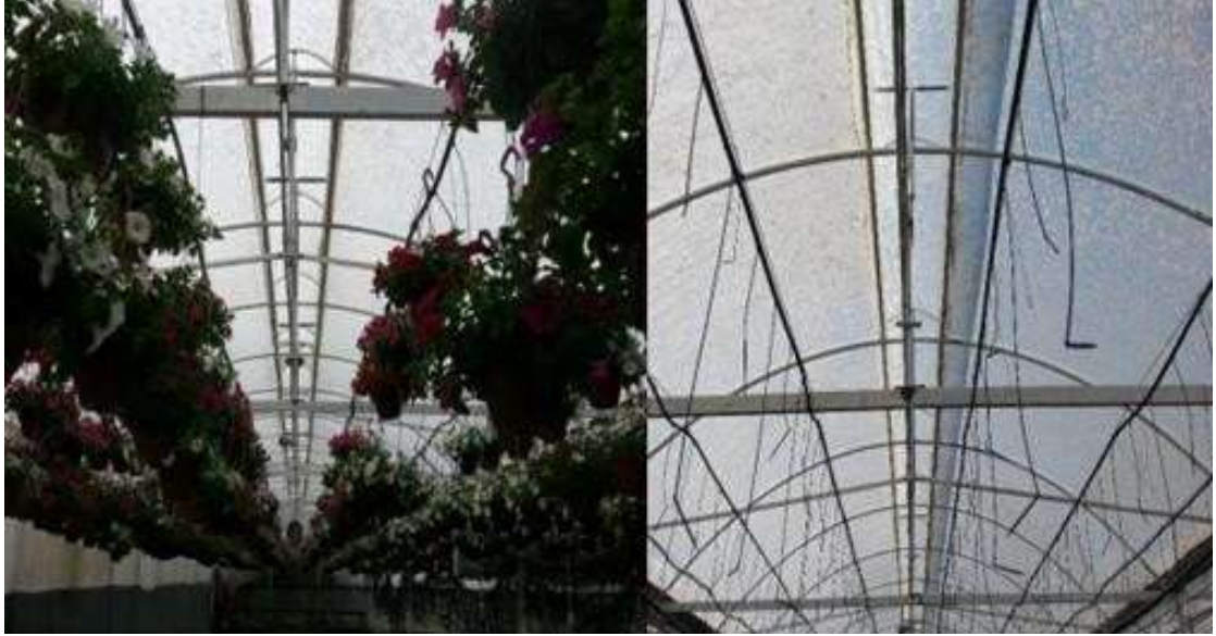
Şekil 2.14. Plastik örtülü seralarda çatı havalandırması
