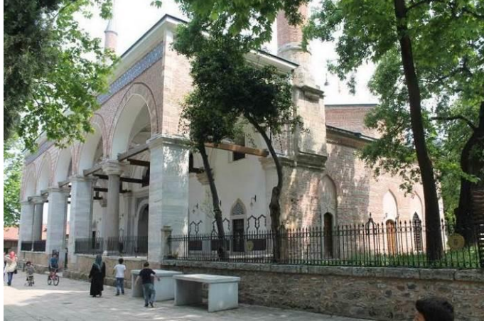
Şekil 4.55. Muradiye Cami kuzeydoğu görünüşü (Sağlık arşivi 2016)
