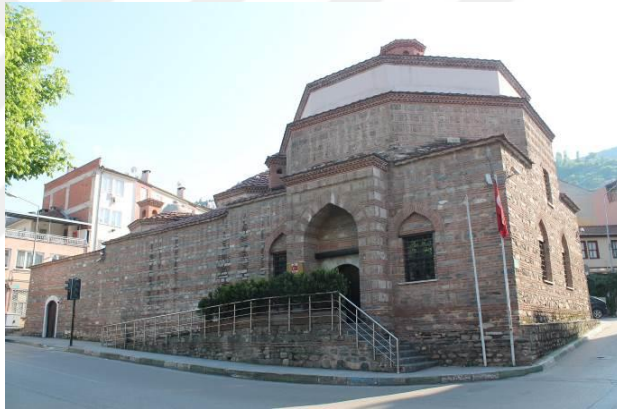
Şekil 4.63. Muradiye Hamamı giriş cephesi (Sağlık arşivi 2016)
