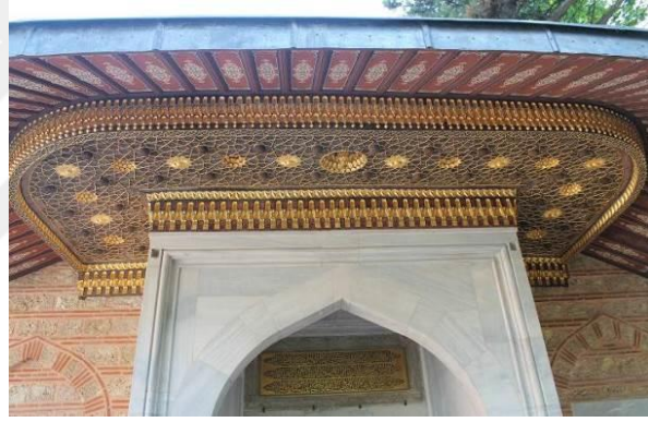
Şekil 4.66. II. Murad Türbesi giriş saçağı (Sağlık arşivi 2016)
