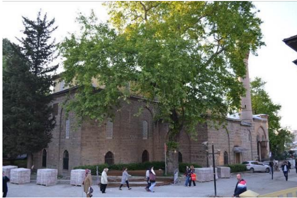
Şekil 4.7. Orhan Cami güneydoğu görünüşü (Sağlık arşivi 2016)
