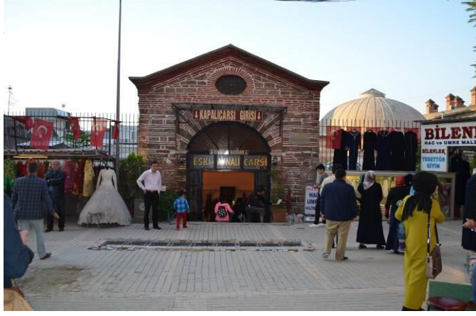
Şekil 4.13. Orhan Hamamı (Aynalı Çarşı) giriş cephesi (Sağlık arşivi 2016)
