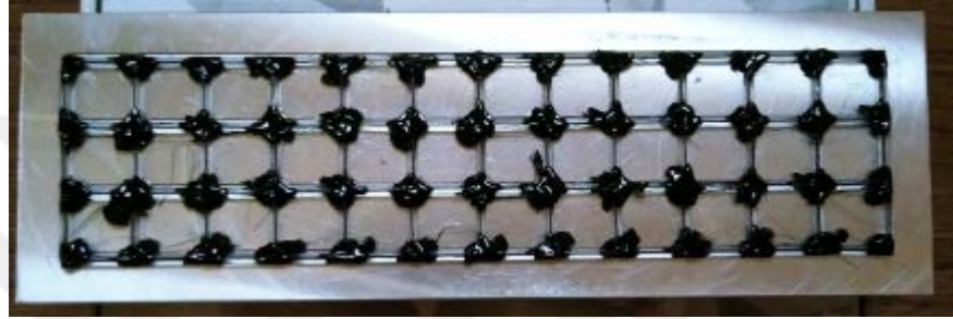
Şekil 3.21 A ve B modeline ait kafes yapının kalıptan sökülmesi
