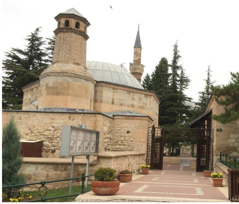
Şekil 4.43.Aşevi batı cephesinden görünüm (Yılmaz 2016)
