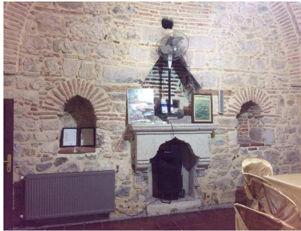
Şekil 4.37. Oda içerisinde bulunan ocak ve dolap nişleri (Yılmaz 2016)
