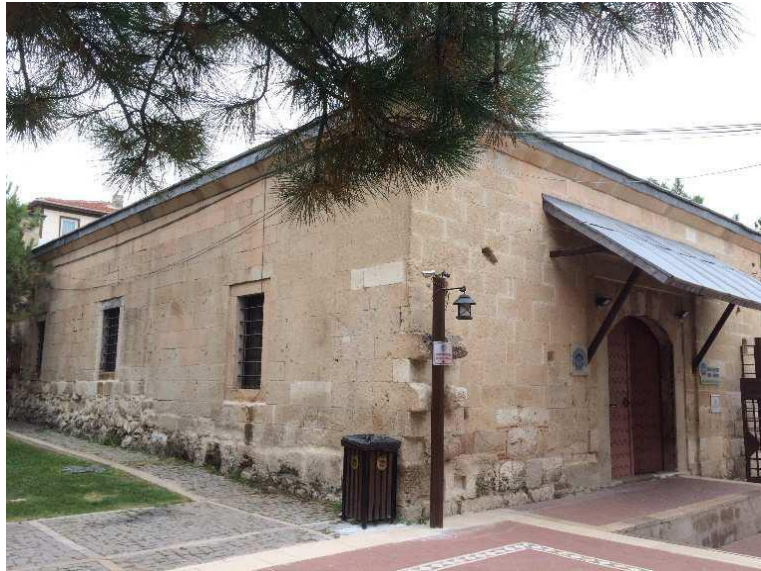
Şekil 4.41. Doğu cepheden görünüm (Yılmaz 2016)
