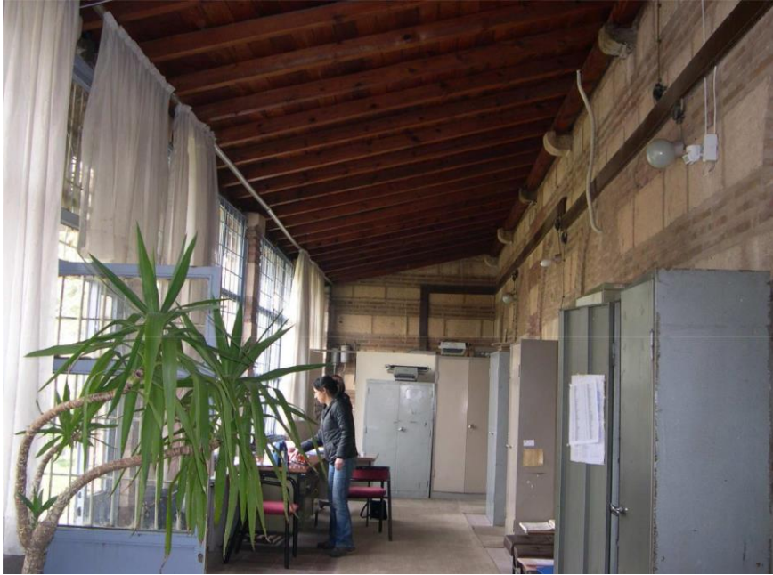
EK 16. Kurşunlu Külliyesi Tabhane İçerden Görünüm
