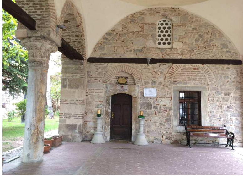
Şekil 4.28.Sıbyan mektebi revaklı girişten görünüm (Yılmaz 2016)
