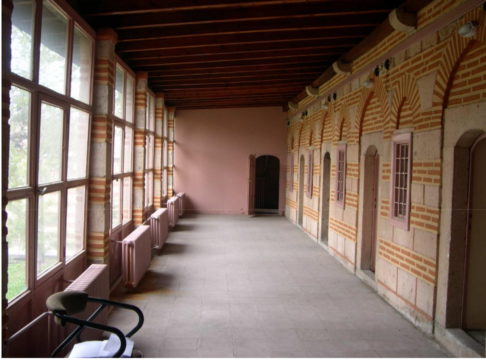
EK 9. Kurşunlu Külliyesi Medrese İçerden Görünüm
