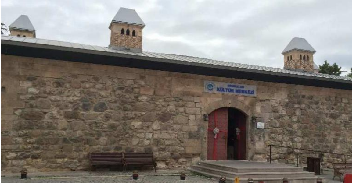
Şekil 4.44. Kervansaray kuzey cephede bulunan girişi (Yılmaz 2016)
