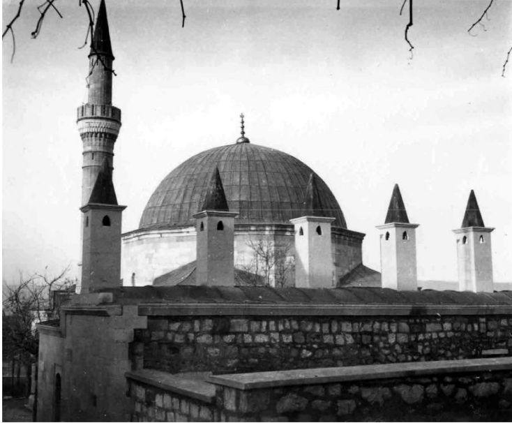
EK 2. Kurşunlu Külliyesi Cami ve Medreseden Görünüm
