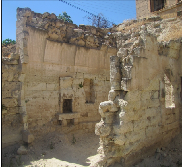
Şekil 2.32. Duvar kesitinde görülen bağlayıcı şillez malzemesi (Ürgüp, Mustafapaşa Köyü, 42 pafta, 5005 parsel)
