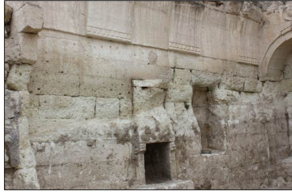
Şekil 3.65. Toprak kotuna yakın yerlerde su ve nemden kaynaklı erimiş ve yüzey kaybına uğramış taşlar
