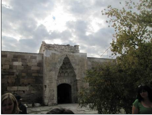
Şekil 2.10. Aksaray Sultanhan cephesi
