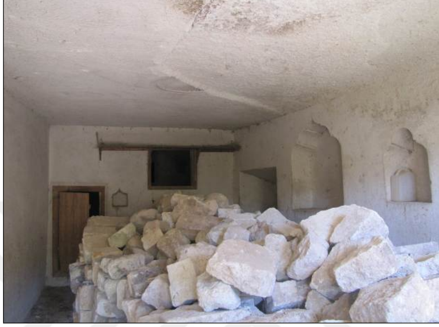
Şekil 3.21. Z09 No'lu odanın kuzey duvarına bakış
