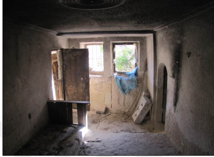
Şekil 3.7. Z03 No'lu odanın kuzey duvarından bakış
