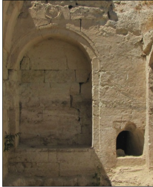
Şekil 3.6. Z01 No'lu odadan Z02 No'lu odaya bakış penceresi
