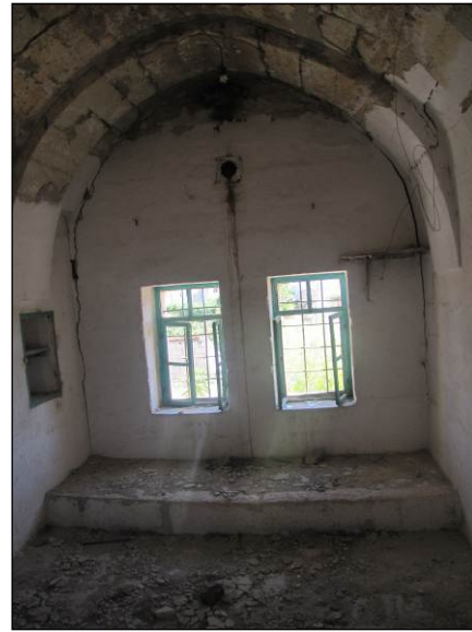
Şekil 3.41. 102 No'lu odanın kuzey duvarı
