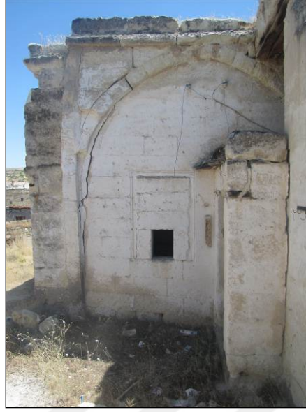
Şekil 4.12. Kuzey duvarında bulunan sonradan küçültülmüş pencere
