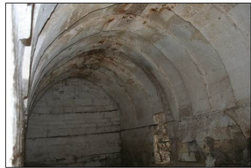
Şekil 2.36. Kemerli tonoz oda örneği
