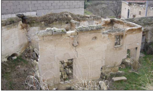
Şekil 4.16. Alt kot avlunun güney duvarındaki mekanlar (NKVKBK arşivi)
