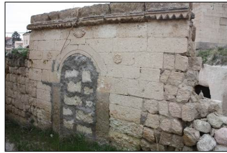
Şekil 3.53. Avlunun güneydoğu cephesi
