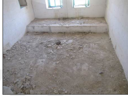
Şekil 3.43. Zemin taş döşemesi
