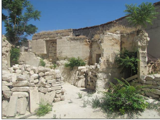
Şekil 3.59. Alt kot avluda bulunan yıkılmış mekanlar
