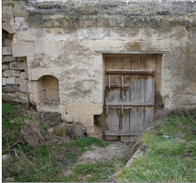
Şekil 4.19. Alt kot avlu güney duvarından helaya açılan ahşap kapının fotoğrafı
