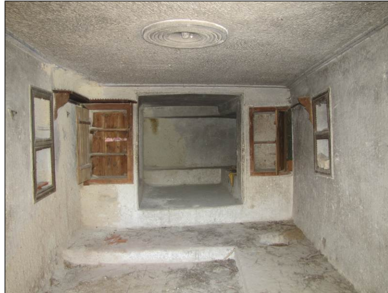
Şekil 3.8. Z03 No'lu odanın güney duvarından bakış
