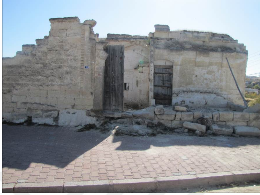
Şekil 3.50. Üst kot avlu duvarı
