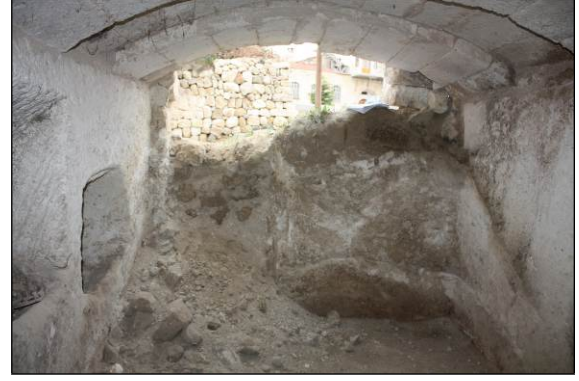
Şekil 3.34. Z05 No'lu odanın batı duvar ve tonoz üst örtüsü
