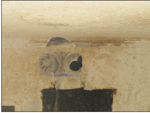
Şekil 3.30. Z11 No'lu odanın kuzey duvarı süslemeleri
