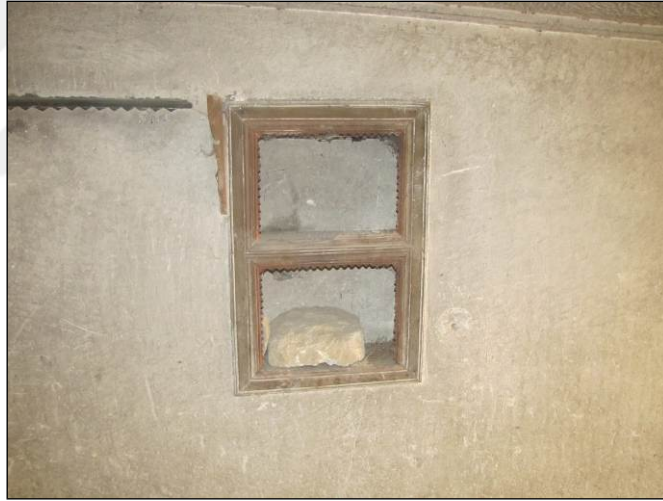
Şekil 3.13. Z03 No'lu odanın doğu duvarında bulunan niş
