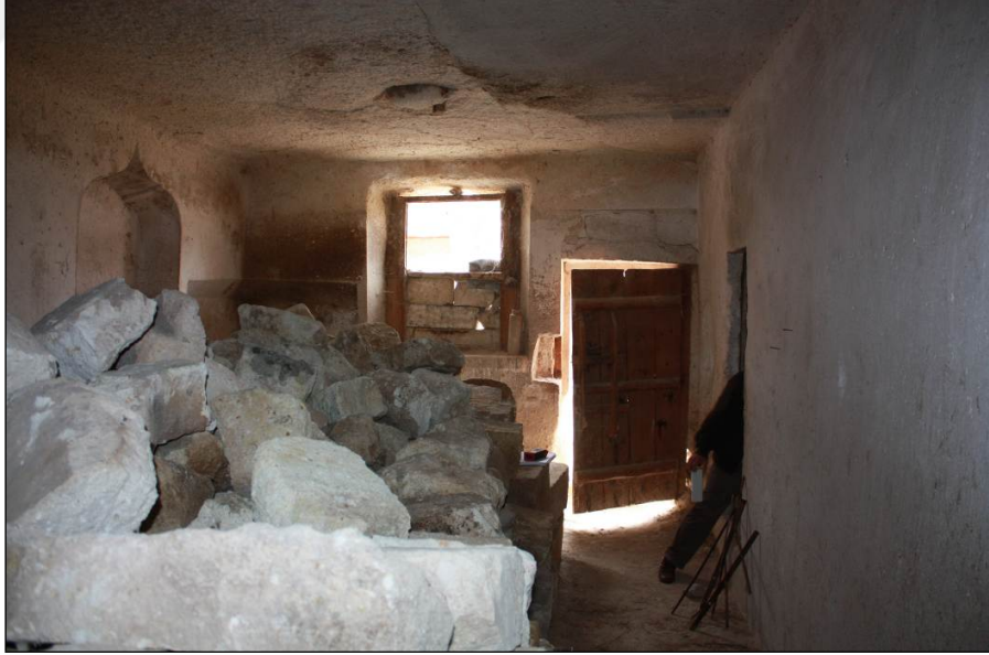
Şekil 3.22. Z09 No'lu odanın güney duvarına bakış
