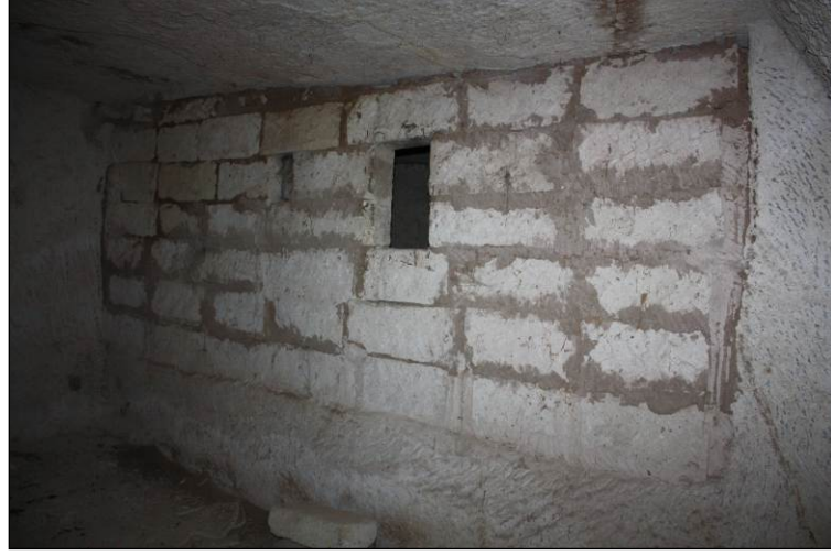
Şekil 4.15. Sonradan yapılmış kesme taş duvar
