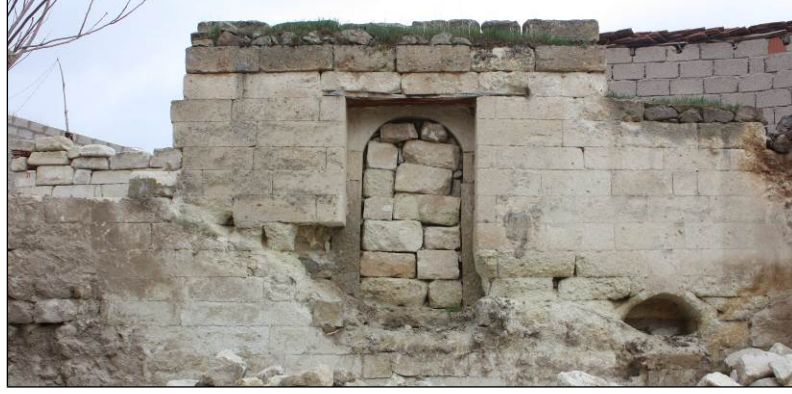
Şekil 4.20. Avlu duvarı üzerindeki merdiven izi
