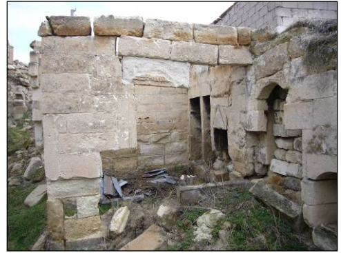
Şekil 4.17. Alt kot avlunun güney duvarındaki mekanlar (NKVKBK arşivi)
