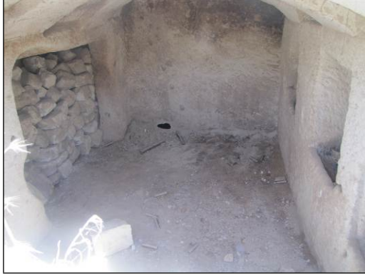
Şekil 3.33. Z05 No'lu odanın doğu duvarı
