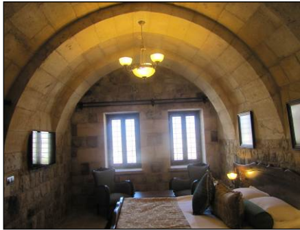
Şekil 2.35. Kemerli tonoz oda örneği
