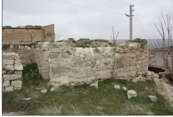
Şekil 3.45. Üst kat avlunun doğusunda yer alan yapı kalıntısı
