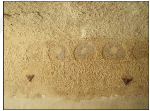
Şekil 3.31. Z11 No'lu odanın batı duvarı süslemeleri
