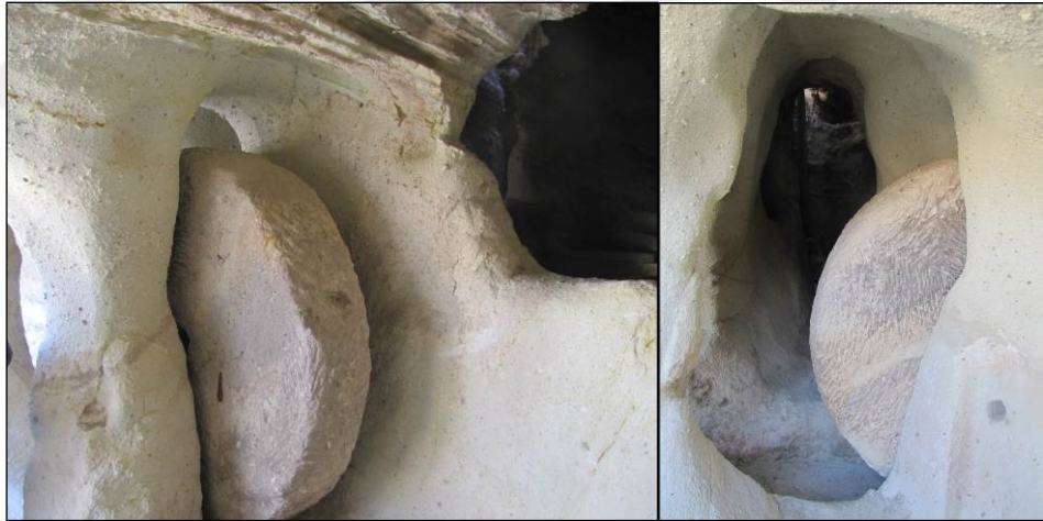
Şekil 2.13. Yeraltı şehirlerinin koridorlarını kapatan sürgü taşı örneği
