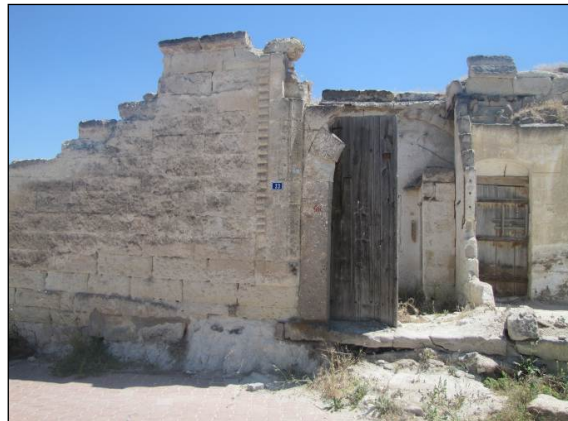
Şekil 3.58. Yıkılan üst kot avlu giriş kapısı
