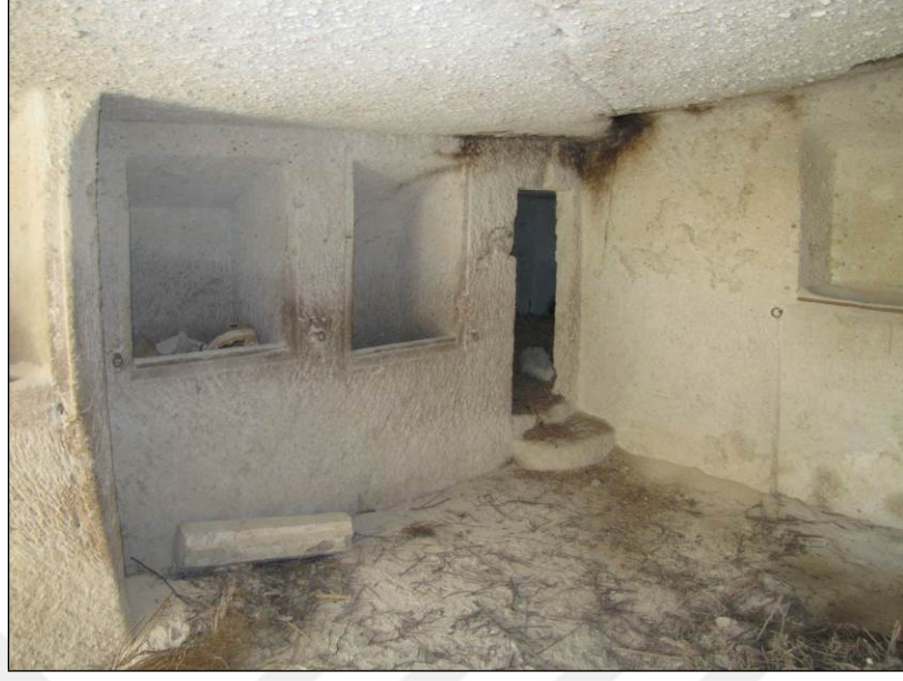
Şekil 3.26. Z10 No'lu odanın kuzey duvarına bakış
