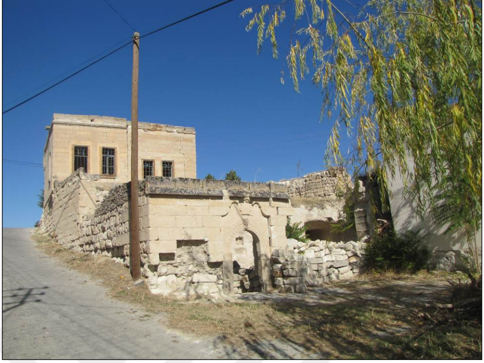
Şekil 3.3. Yapının güneybatı görünüşü
