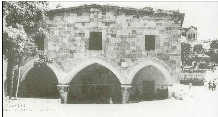
Şekil 2.56. 1729 tarihli Konstantin ve Eleni Kilisesi batı cephesi (Balta 2007)
