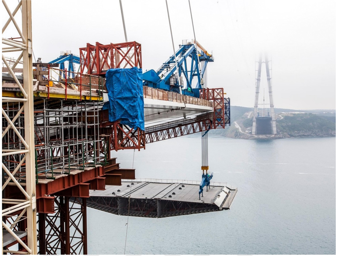
Şekil 4.6. Yavuz Sultan Selim köprüsü inşaatında çalışma platformları kenarlarına yapılmış korkuluk örnekleri
