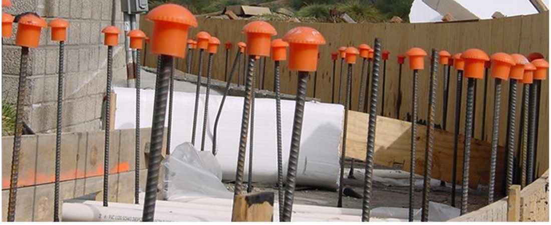
Şekil 4.10. Demir filizleri başlarına takılan plastik pabuçlar
