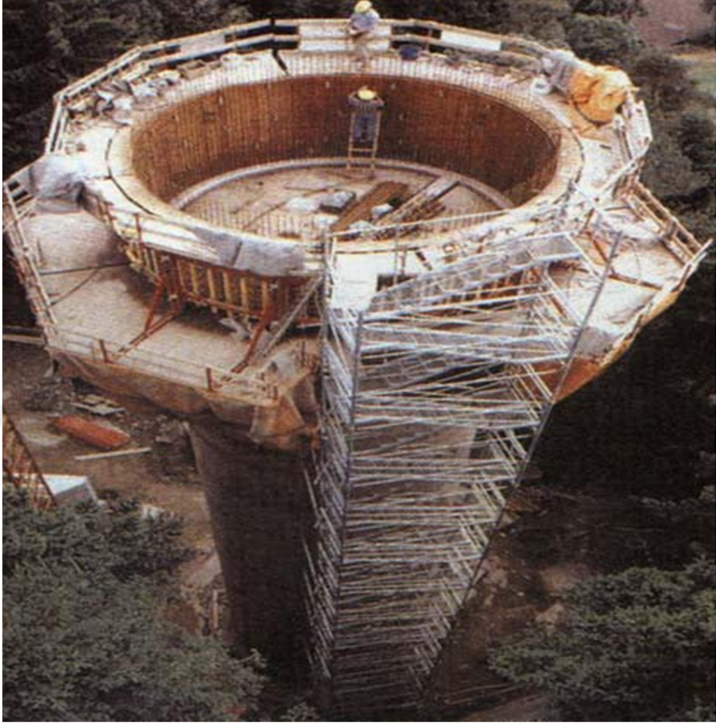
Şekil 4.3. Viyadük ayağı inşaatında çalışma bölgesine yapılmış olan korkuluklar
