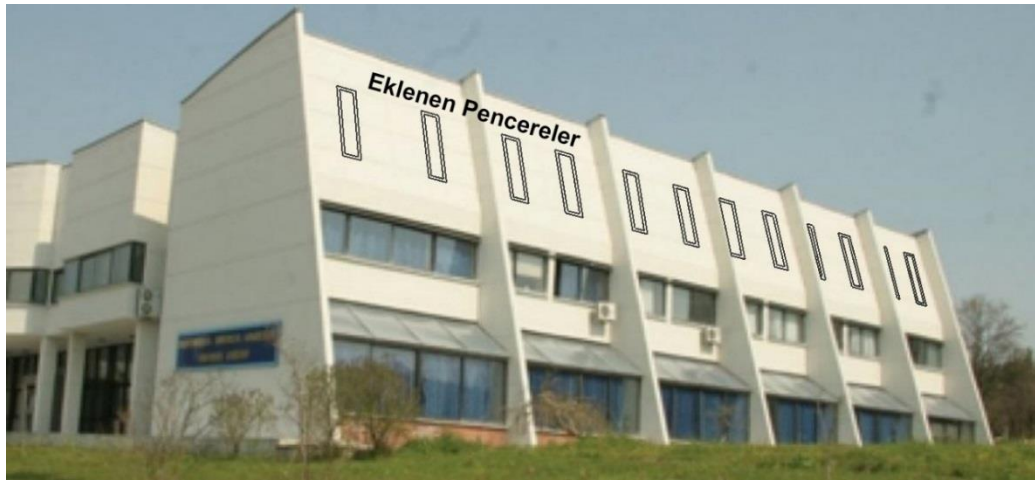
Şekil 6.33 Binanın sağ ve sol cephelerinde çatı katında dışarıya bakacak şekilde yerleştirilen pencereler
