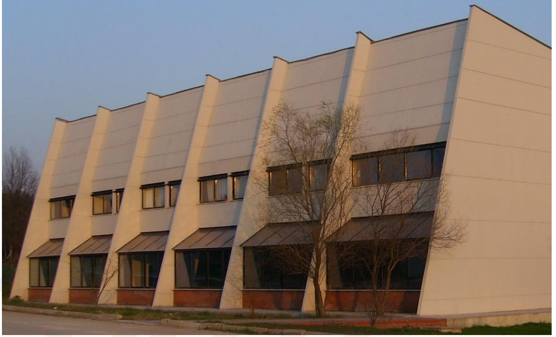
Şekil 6.27 Uludağ Üniversitesi Mimarlık Bölüm Binası sol cephesi (Anonim 2016a)
