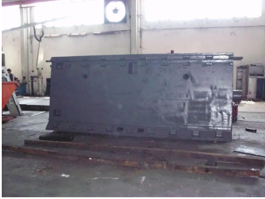
Şekil 5.64.Dökülmüş yan duvarlar
