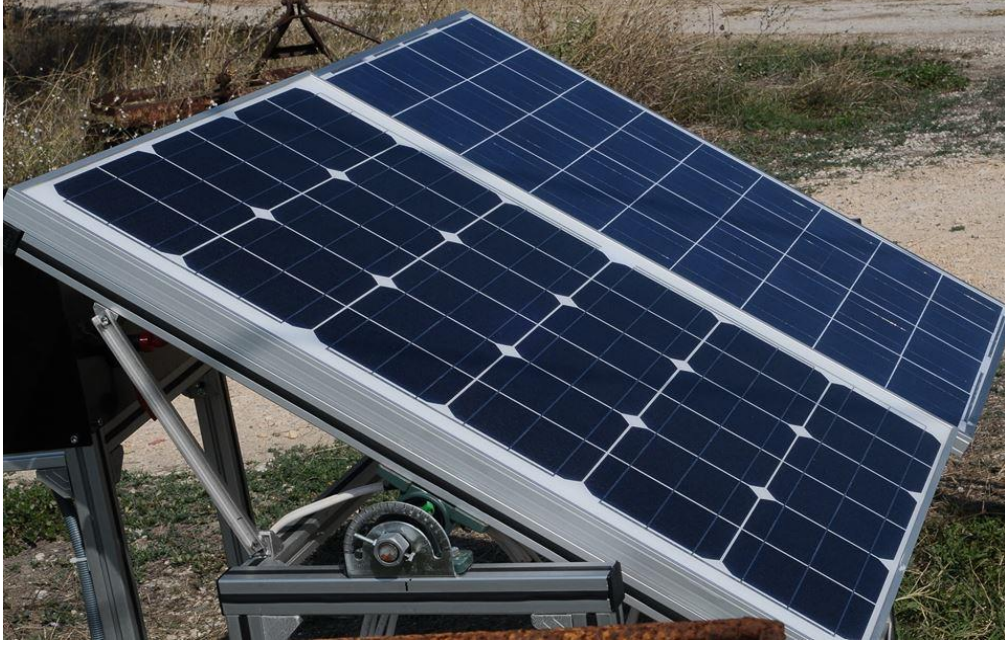
Şekil 3.26.30°’lik açı ile uygulanan ve güney yönüne bakan güneş panelleri
